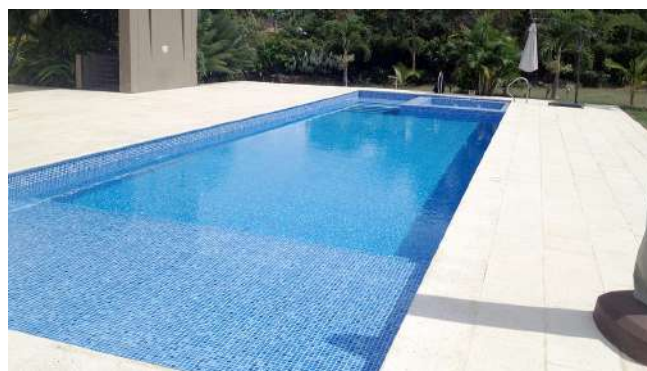
Acabado con membrana ALKORPLAN 3000 PERSIA AZUL Renolit
